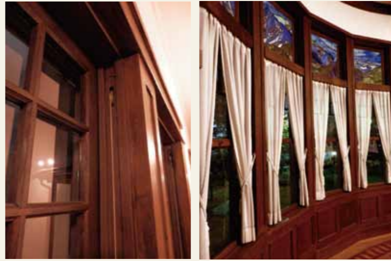
窓枠の滑車とワイヤー
