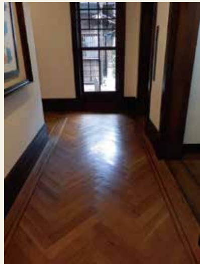
廊下のヘリンボーン張り
